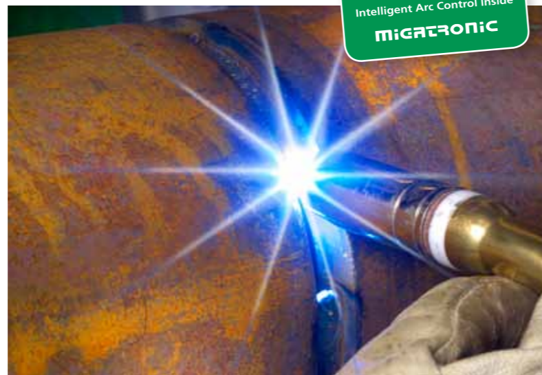
IAC™ senkrecht nach unten gerichtetes Schweißen einer Wurzellage einer Fernwärmeleitung. Deutliche Verbesserung der Schweißgeschwindigkeit verglichen mit dem traditionellen nach oben gerichteten Schweißen.
